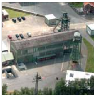
De site met de twee schachtbokken gezien vanuit de lucht
