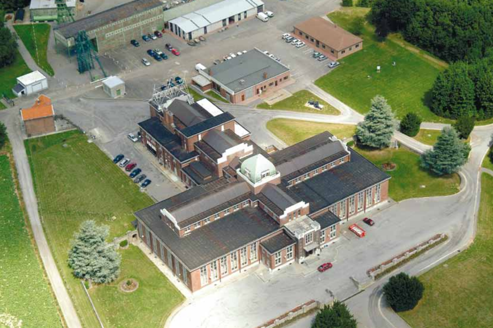
Het station van Vedrin (foto AIP)
