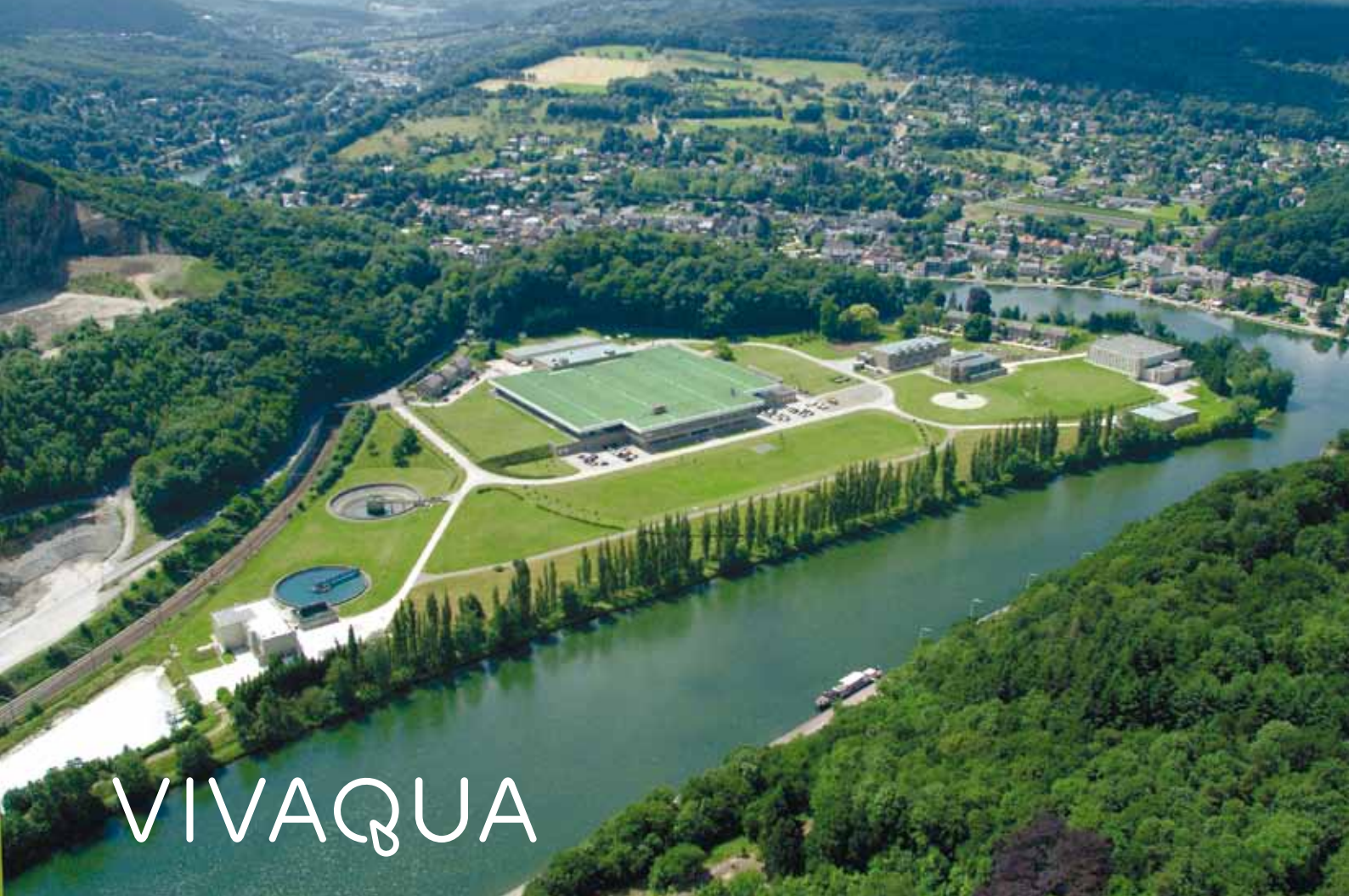
Het complex van Tailfer (foto AIP)
