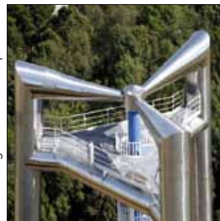
Rol van de drievoet van Mazy: de druk in de feeders en leidingen temperen
