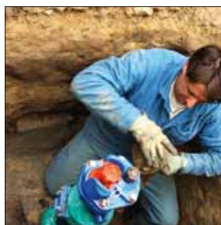
De plaatsing van een hydrant
