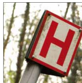
Bordje dat wijst op de aanwezigheid van een ondergrondse hydrant
