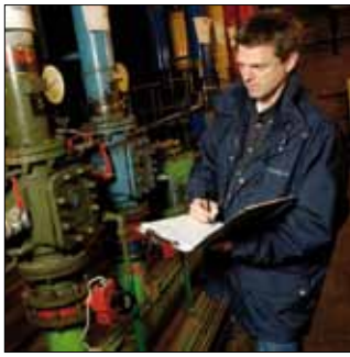
Controle van een sprinklerinstallatie
