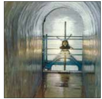
De onderaardse sluis van de galerij onder het Zoniënwood
