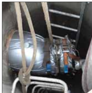
Voorbeeld van conformeringswerkzaamheden: bekleding van een riool
