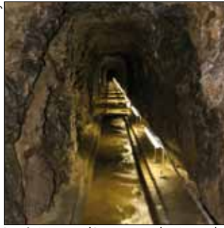
Intérieur d'une galerie de captage principale
