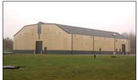
L'usine de nitrification
