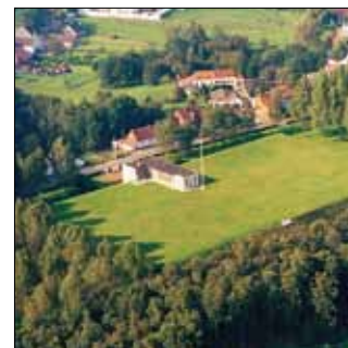
Réservoir du Roelux
