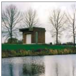
Puits de Ghlin
