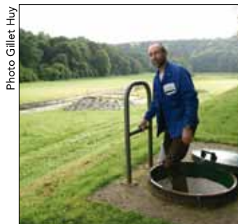
Accès à une galerie de captage
