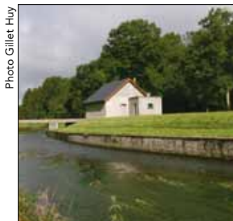
Le Bocq canalisé à Spontin (zone de Senenne)
