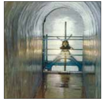
Serrement de la galerie de la Forêt de Soignes
